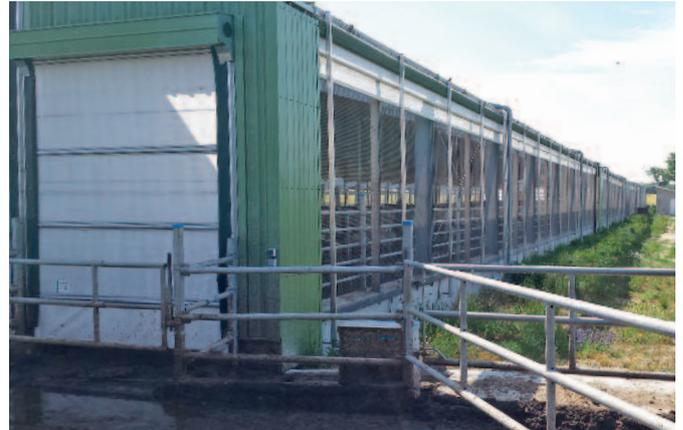
Die Traufseiten der Ställe werden entweder völlig offen gestaltet oder mit mechanisch verstellbaren Wickellüftungen ausgestattet.
