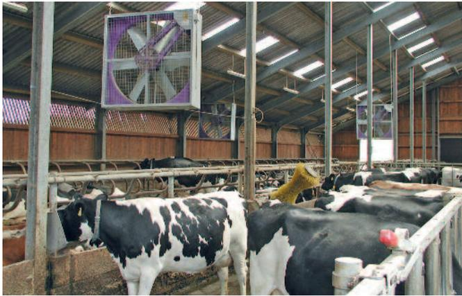
Um das Wohlbefinden der Tiere bei länger anhaltenden Hitzeperioden zu steigern, ist in Rindviehställen der Einbau einer Unterstützungslüftung sinnvoll.
