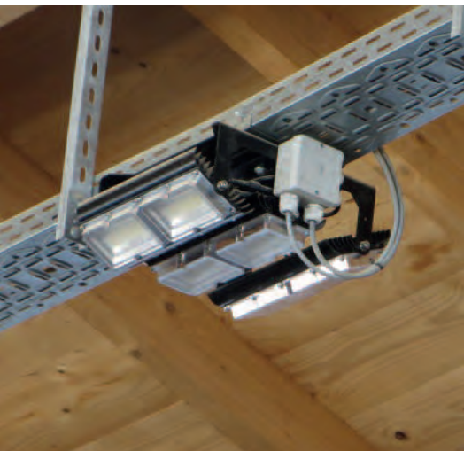
Triplex-LED-Lampe an Kabelschacht montiert.
